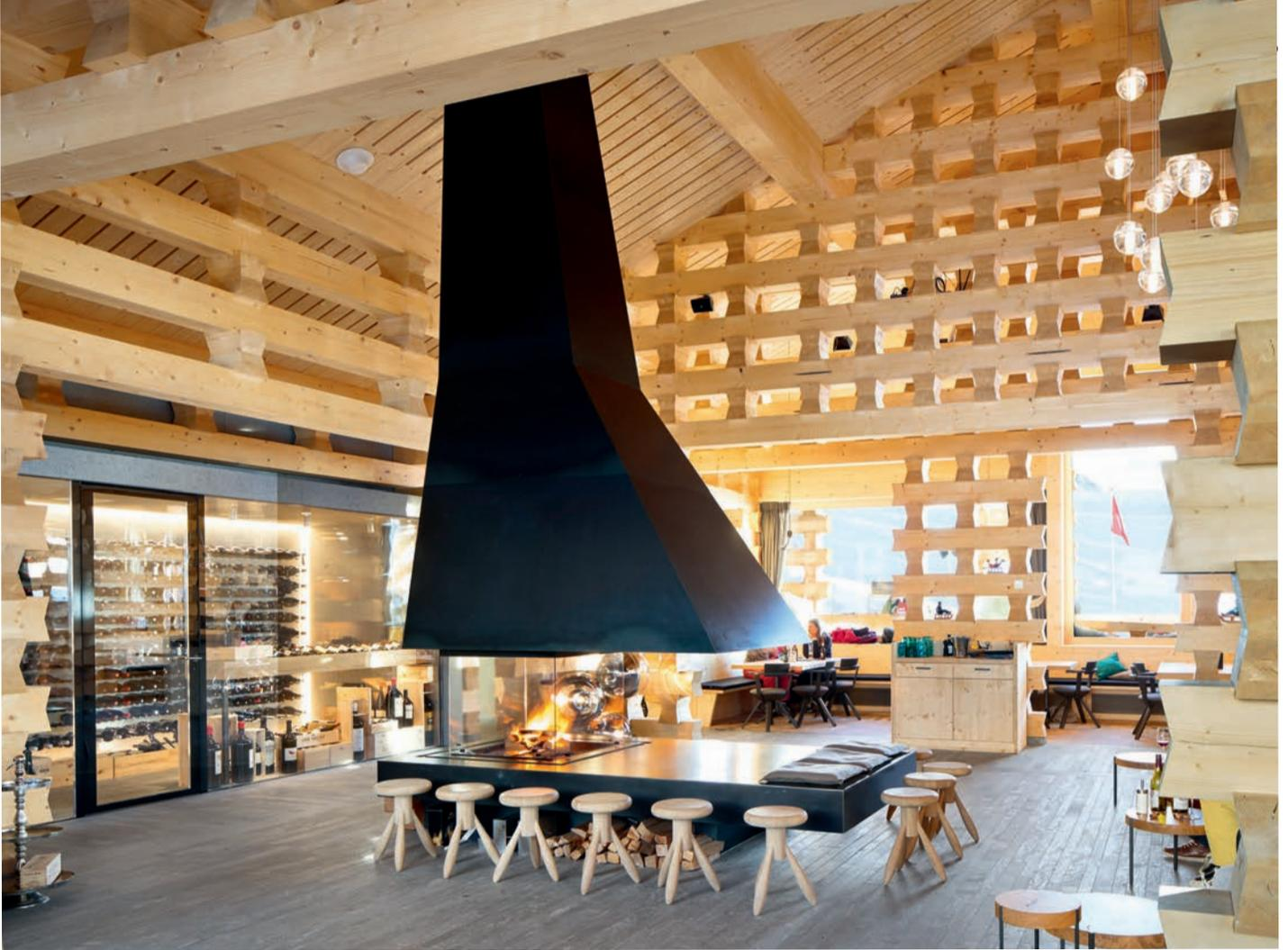
Das Tragwerk ist in offener Strickbauweise konstruiert. Das teils dunkel gehaltene Mobiliar setzt Akzente im hellen Raum.
